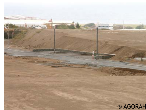
ZI n°4 en cours d'aménagement Saint-Pierre
