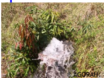
Fuite sur le réseau
