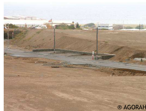
ZI n° 4 en cours d'aménagement Saint-Pierre
