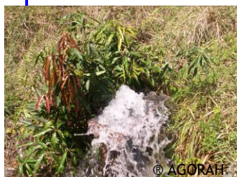
Fuite sur le réseau
