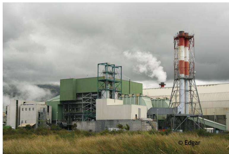
Valorisation de la biomasse pour la production d'énergie, Usine du Gol, Saint-Louis
