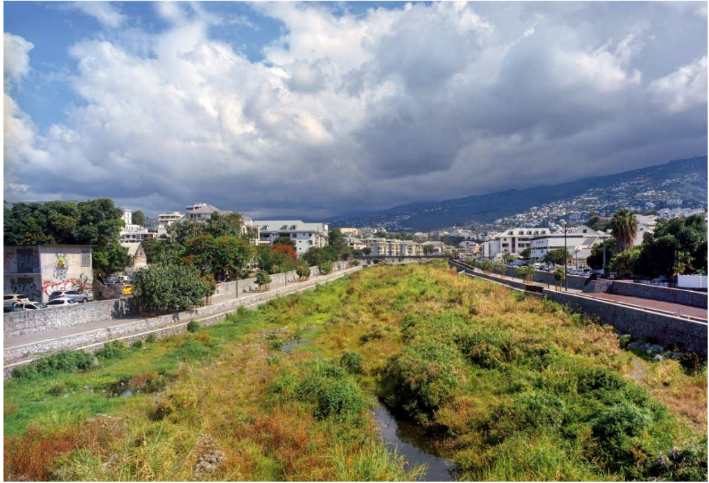
Aménagements paysagers des abords de la rivière de Saint-Denis : exemple de traitement de la Trame bleue faisant conciliation entre usages et gestion des eaux – Réunion © Observatoire des paysages (2012) - DEAL REUNION
