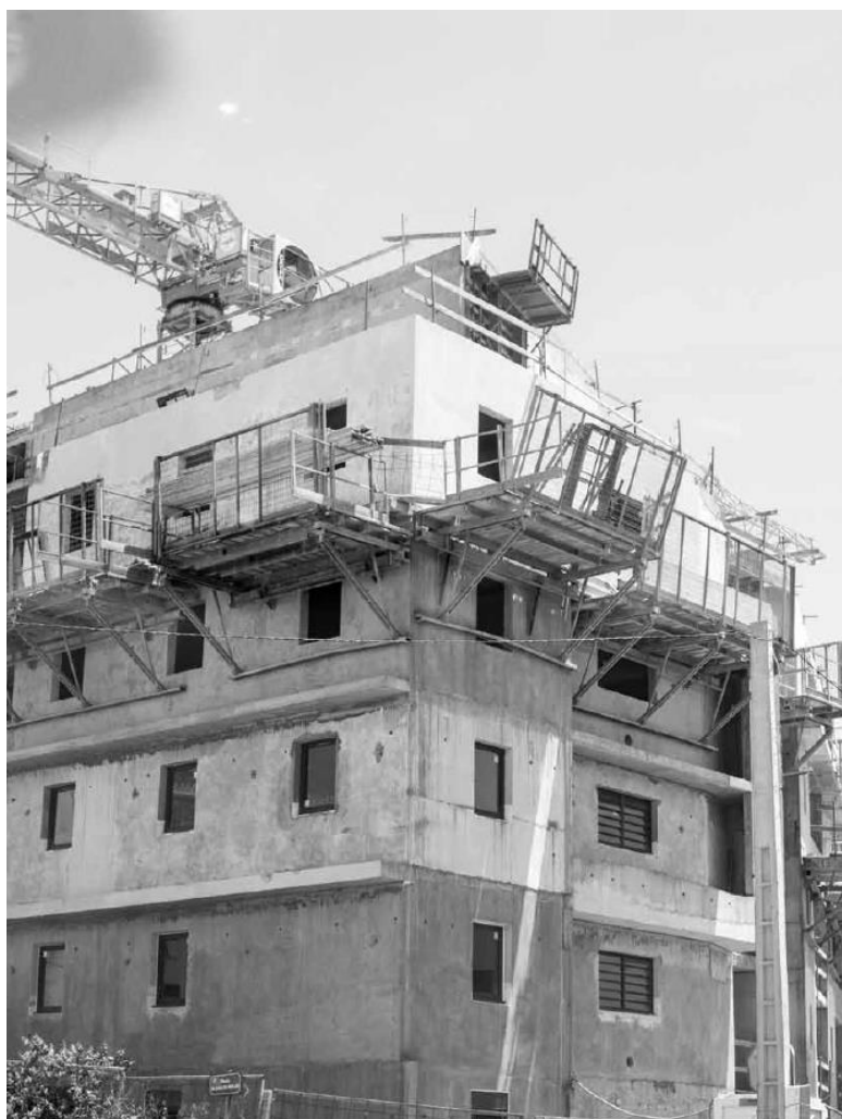
Construction d'un immeuble collectif à La Possession, crédit photo AGORAH
