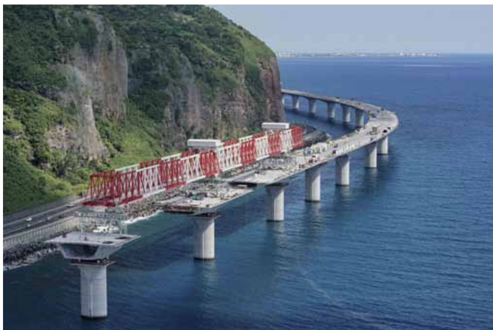
■ Viaduc de la Nouvelle Route du Littoral - NRL
