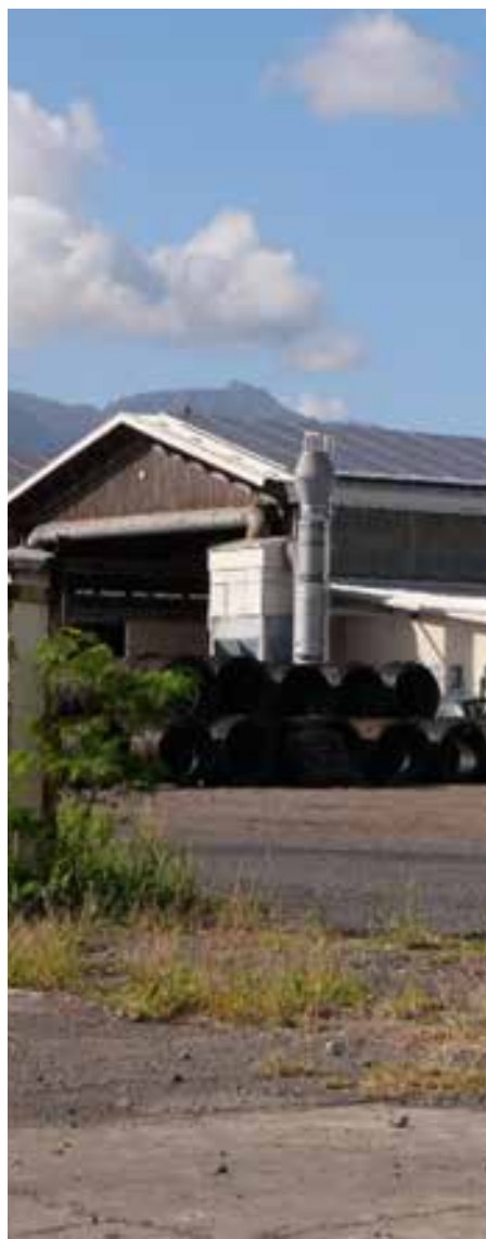
Entrepôt situé dans une ZAE
