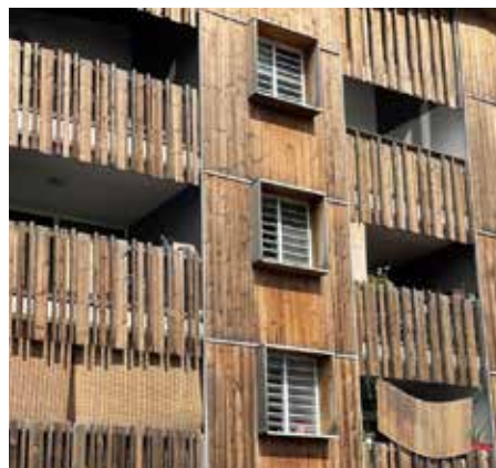
Logement collectif - Sainte-Clotilde - Saint-Denis
